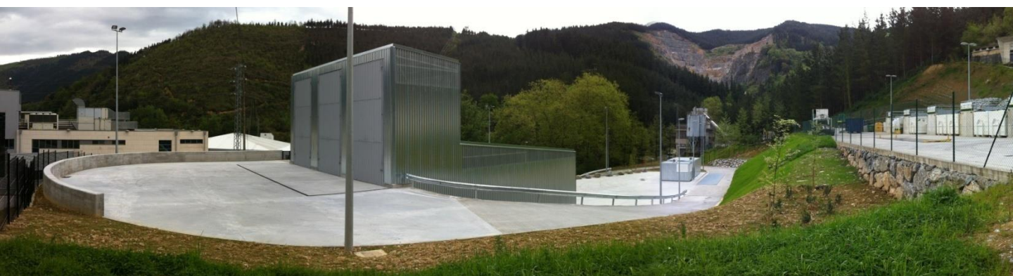
Estación de Transferencia de Debabarrena - ELGOIBAR / GUIPÚZCOA
